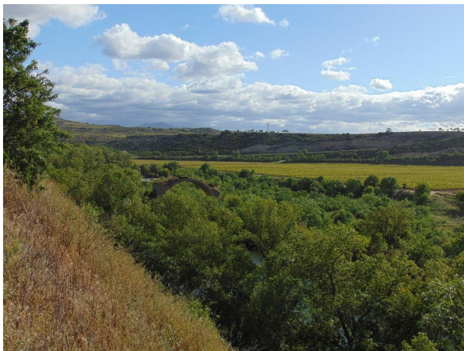
Figura 4. Tramo del puente Mantible, incluido en la zona propuesta. En la fotografía se observa también la parte correspondiente a Álava, protegida.
